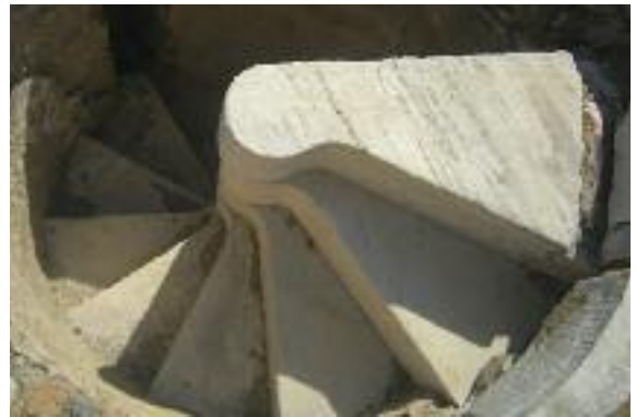
Η μαρμάρινη λαξευτή σπονδυλωτή σπειροειδής σκάλα πριν την αποκατάσταση. The internal marble made, spiral staircase before the restoration project.
