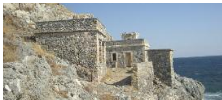
Ο φάρος πριν την αποκατάσταση. View of the lighthouse before the restoration project.
