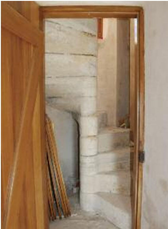
Η σκάλα κατά την αποκατάσταση. The staircase during the restoration.
