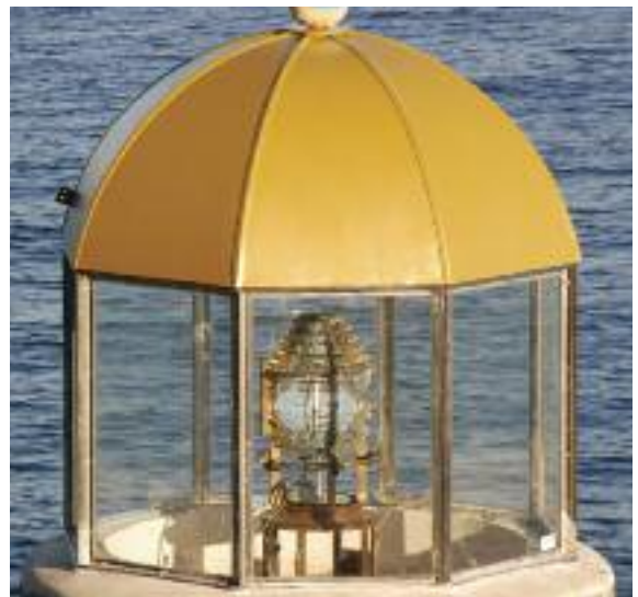
Ο κλωβός με το οπτικό Στ΄ τάξης. View of the tower head, with 6th order light lens in place.
