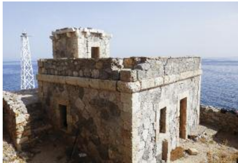
Το φάρουσπιτο με τον πύργο πριν την αποκατάσταση.
